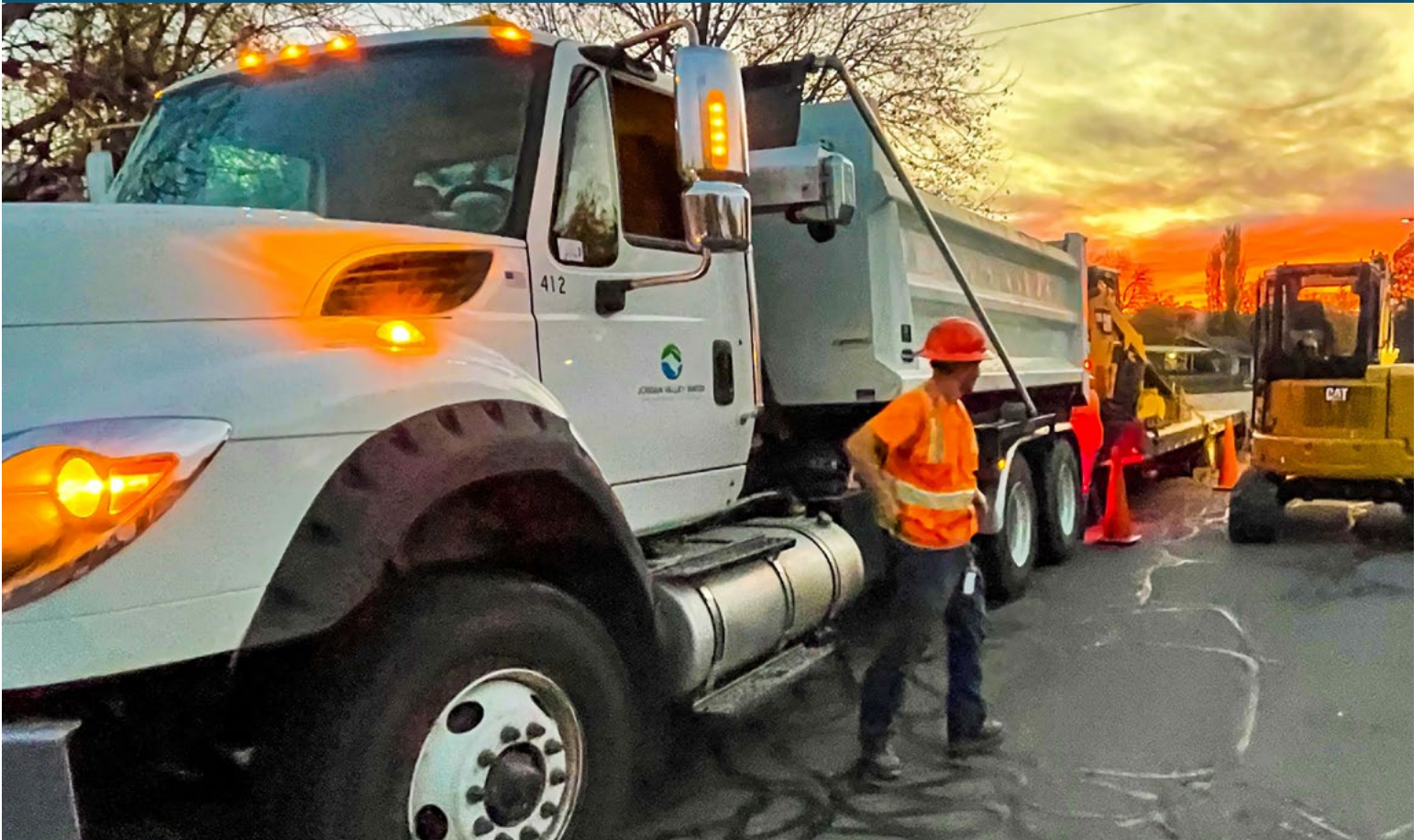
Mainline Break Repair at 1080 E. 5650 S. Murray - E. Estrada
